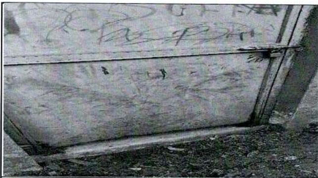
Foto 3: sustitución de puerta
