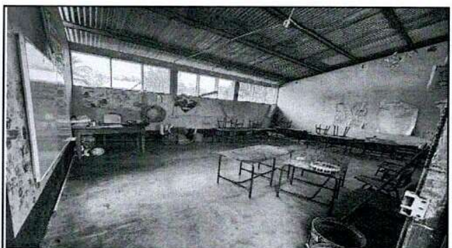
Foto 4: Vista interna de estructura de techo.
