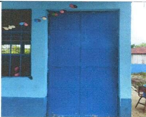
Foto 3: Colocación de la puerta.
