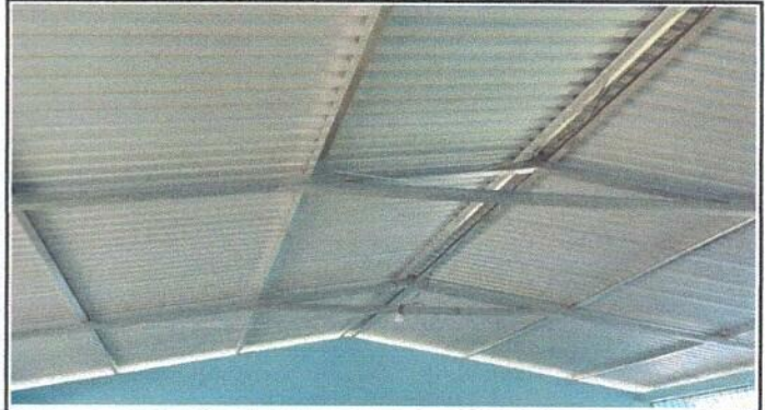
Foto 2: Colocación nueva de estructura de metal.
