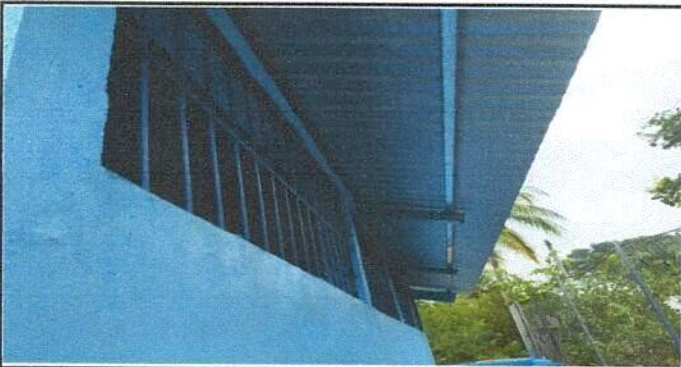
Foto 5: Colocación de balcones, parte trasera.
