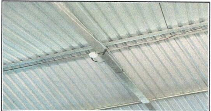
Foto 6: Colocación de servicio de energía eléctrica.
