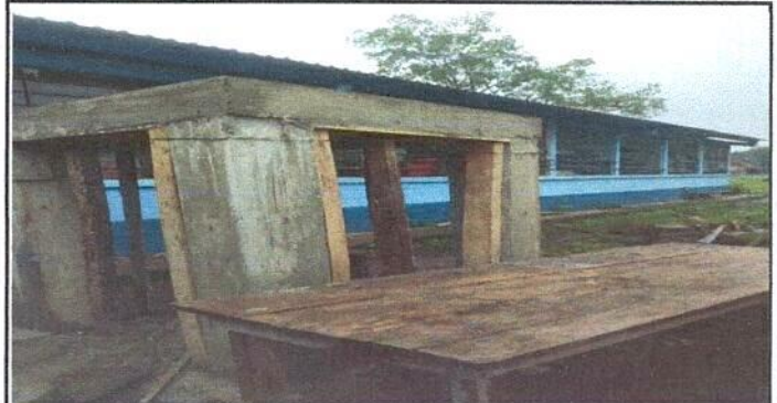
Foto 2: Finalización de los pilares y terraza para colocar el tinaco de 500 ml.
