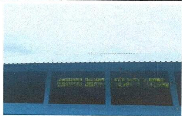
Foto 4: Colocación de balcones, parte delantera.
