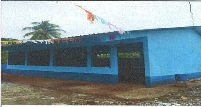
Foto1: Aula Finalizada y Pintada.
