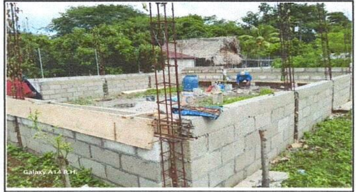
Foto 2: Continuidad de las paredes.
