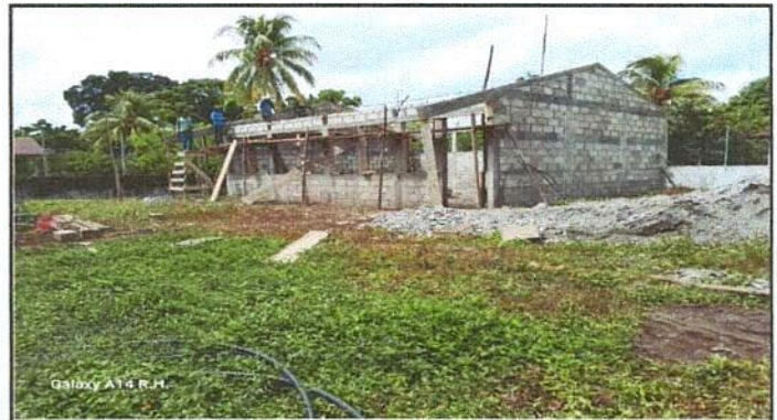
Foto 4: Continuidad de las paredes con mano de obra no calificada de padres de familia.
