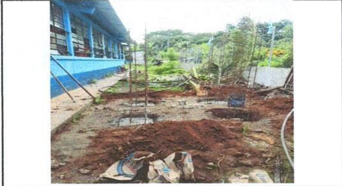
Foto1: Inicio de columnas.
