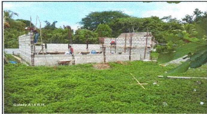
Foto 3: Continuidad de las paredes con mano de obra no calificada de padres de familia.
