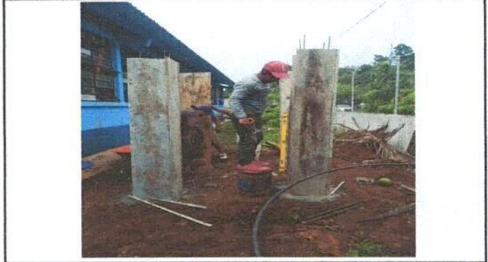
Foto 2: Finalización de columnas.
