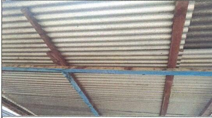
Foto1: Cambio de techo de lámina ondulada por lámina troquelada.
