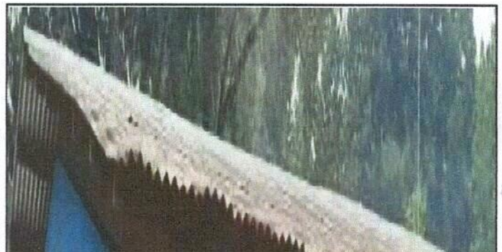
Foto 6: Cambio de láminas oduladas por laminas troqueladas.
