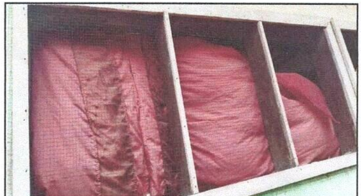
Foto 4: Cambio de ventanas de madera por balcones, parte trasera.
