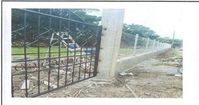
Foto 5: Reparación de muro perimetral de block con tubo y malla galvanizada
