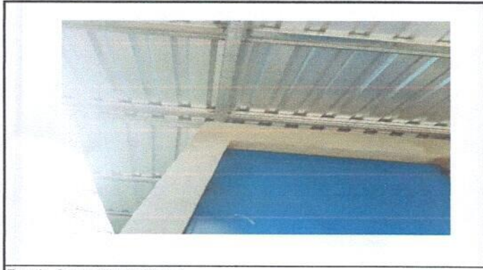
Foto 1: Sustrucción de lámina
