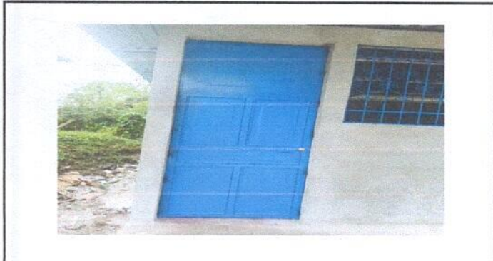
Foto 3: Sustrucción de puertas y ventanas
