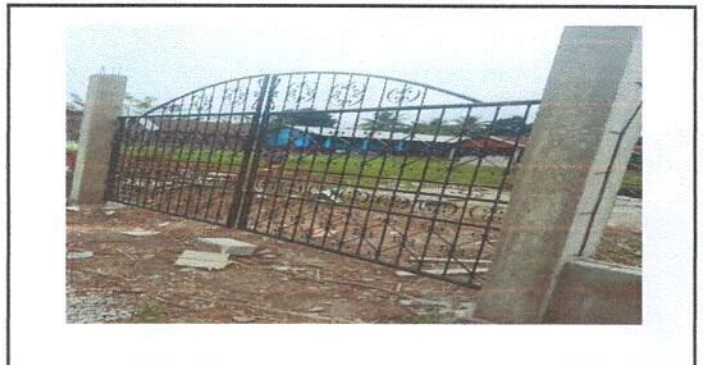
Foto 6: Sustrucción de poton de metal
