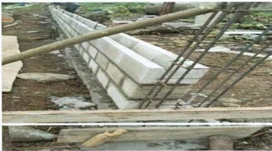
Foto 5: Reparacion de muro perimetral de block con tubo y malla galvanizada
