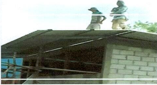
Foto1: Sustitución de lámina
