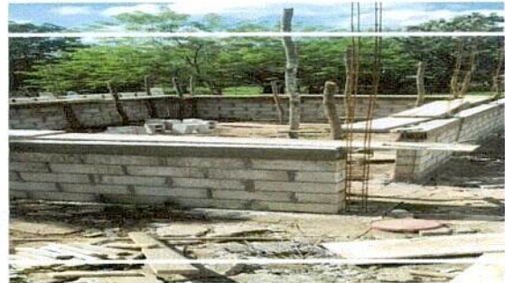
Foto 4: Sustitucion de piso de torta de concreto
