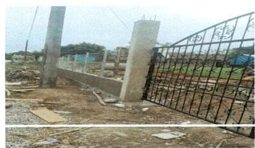
Foto 6: Sustitucion de poton de metal
