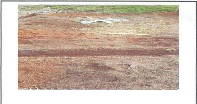
Foto 4: Sustrucción de piso de torta de concreto
