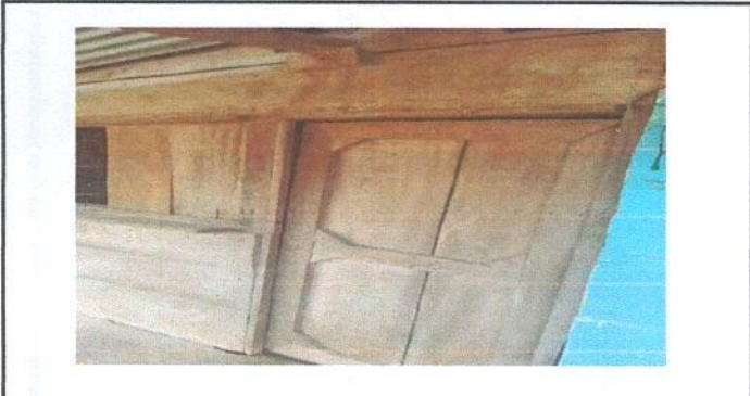
Foto 3: Sustrucción de puertas y ventanas
