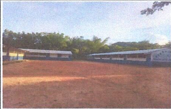
Foto 1: Sustrucción de puertas
