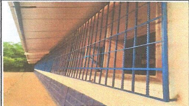
Foto 2: Mantenimiento a estructuras de metal de ventanas
