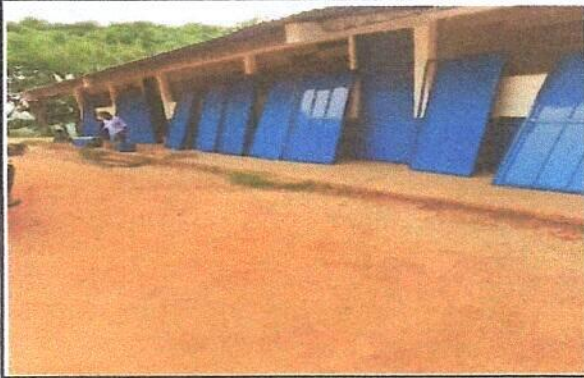
Foto 1: Sustrucción de puertas
