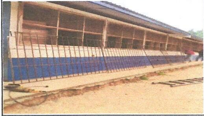
Foto 2: Mantenimiento a estructuras de metal de ventanas
