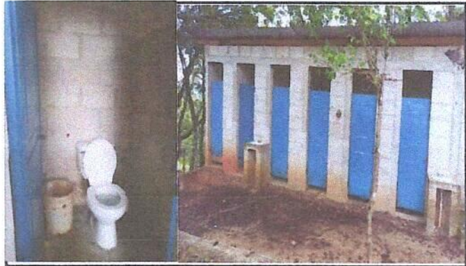
Foto 4: Sustitución de inodoros
