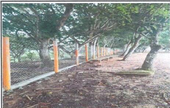
Foto 1: Muro de contención (solera de humedad)
