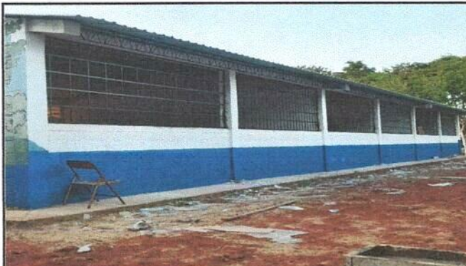
Foto 4: Sustitución de estructura de metal de ventanas
