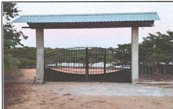
Foto 3: Sustitución de Portón de metal
