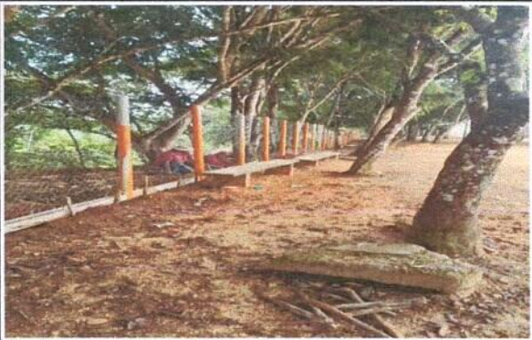
Foto 1: Reparación de muro de contención (soloera de humedad)
