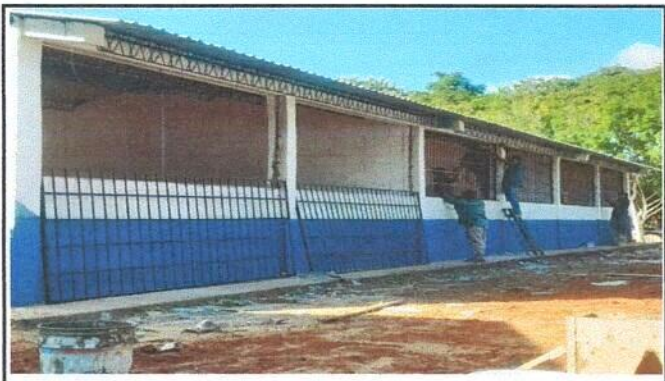
Foto 4: Sustitución de estructura de metal de ventana
