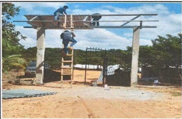
Foto 3: Sustitución de portón de metal
