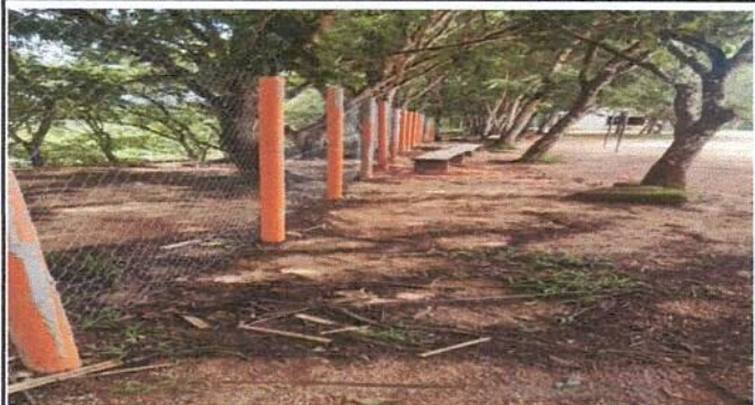
Foto 1 Muro de contención (solera de humedad)
