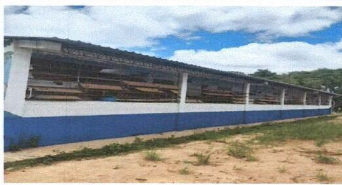
Foto 4 Sustitucion de estructura de metal de ventanas
