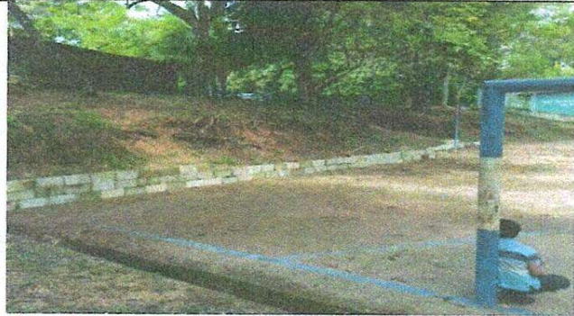
Reparación de muro perimetral de block
