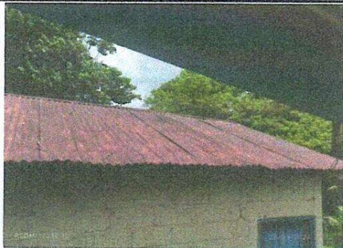
Sustitución de lámina, por lámina troquelada Alucinc calibre 26
