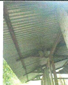
Sustitución de estructura de sopoprte de madera por metal
