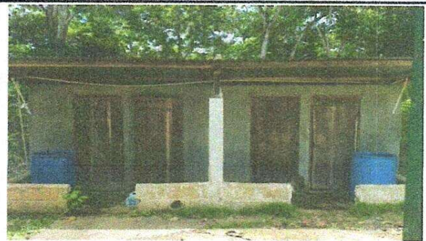
Sustitución de puerta en servicio sanitario
