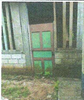
Sustitución de puerta para cocina
