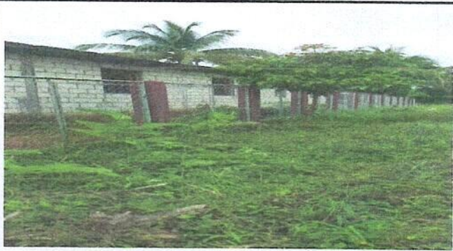
Foto 5: Reparación de muro. Tubo hg y maya galvanizada.
