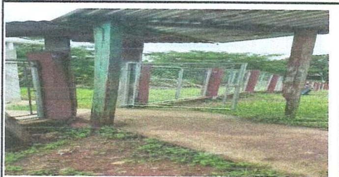
Foto 4: Reparación de muro. Tubo hg y maya galvanizada.
