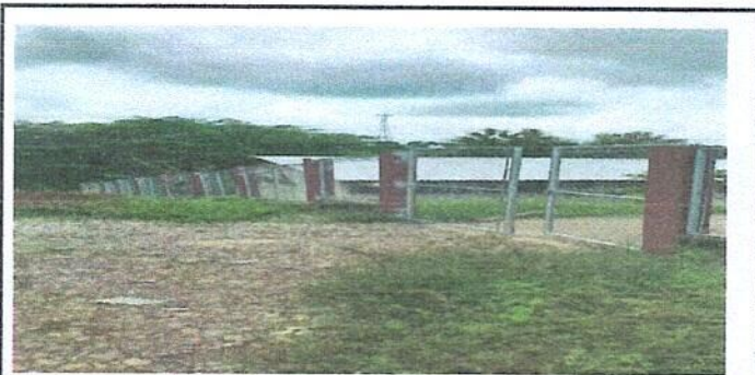
Foto 6: Reparación de muro. Tubo hg y maya galvanizada.
