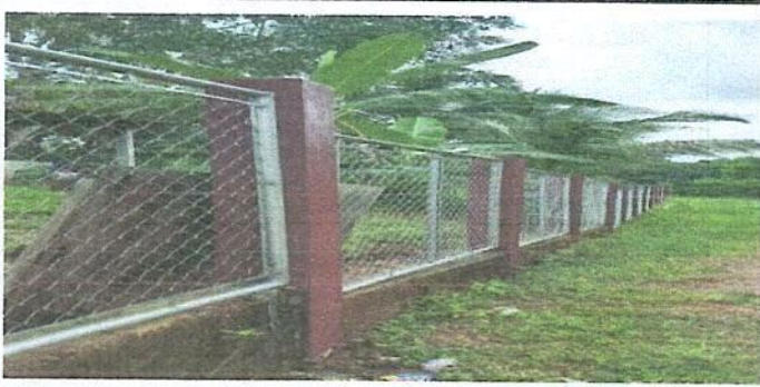
Foto 3: Reparación de muro. Tubo hg y maya galvanizada.
