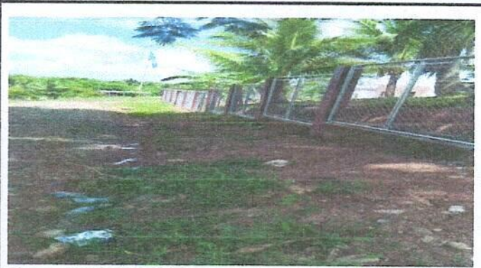
Foto 2: Reparación de muro. Tubo hg y maya galvanizada.
