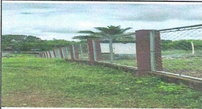
Foto 3: Reparación de muro. Tubo hg y maya galvanizada.
