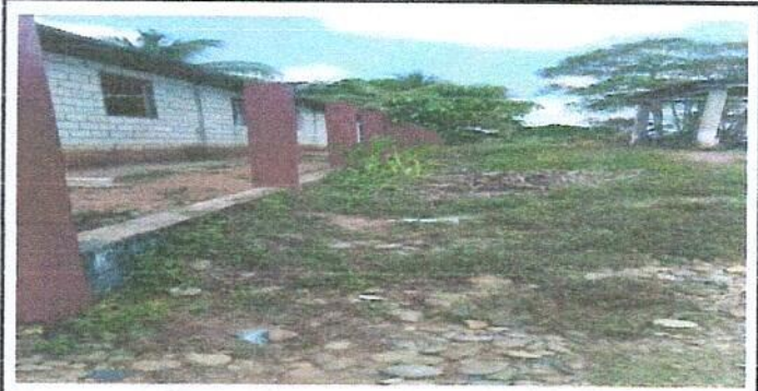
Foto 2: Reparación de muro. Tubo hg y maya galvanizada.
