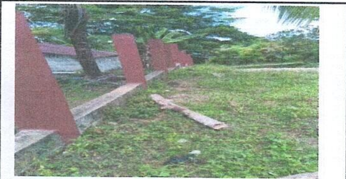
Foto 5: Reparación de muro. Tubo hg y maya galvanizada.
