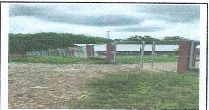
Foto 6: Reparación de muro. Tubo hg y maya galvanizada.
