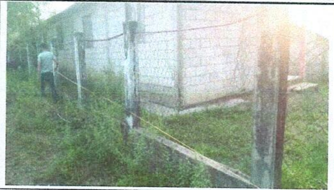
Foto 2: Reparación de muro. Tubo hg y maya galvanizada.
