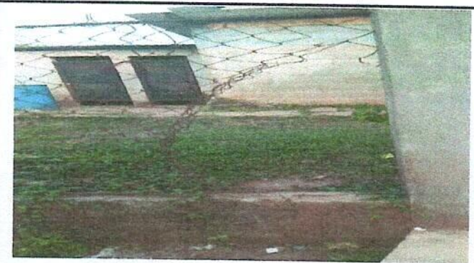
Foto 4: Reparación de muro. Tubo hg y maya galvanizada.
