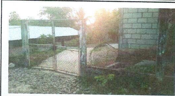
Foto 1: Reparación de muro. Tubo hg y maya galvanizada.
