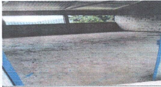
Foto 6: Sustitución de torta de piso de cemento.
