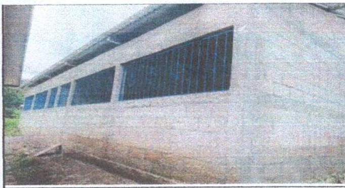
Foto 5: Sustitución de balcones de metal.
