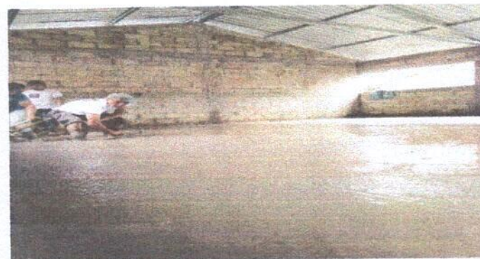
Foto 6: Sustitucion de piso de torta de concreto.
