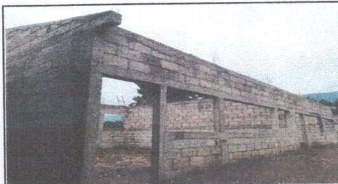
Foto 4: Sustitución de puerta.
