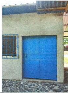
Foto 2: Sustitución de puertas.
