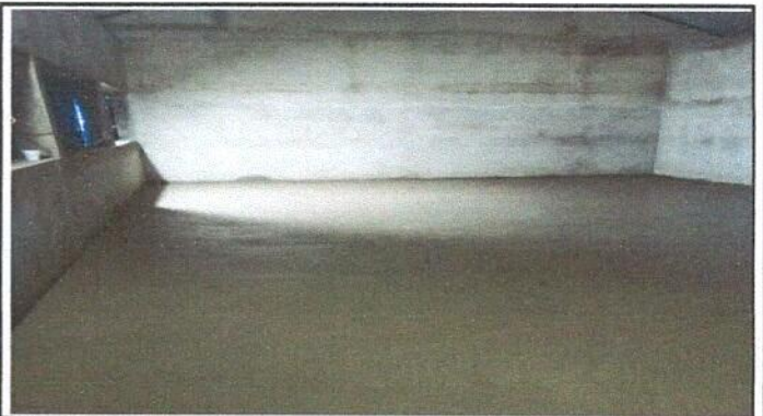
Foto 4: Reparación de piso.
