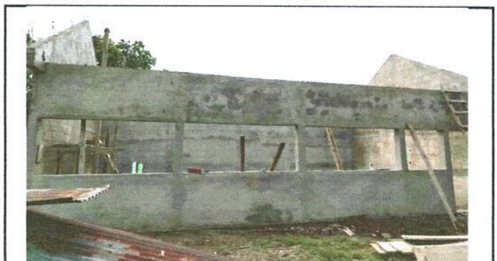
Foto 6: Sustitución de balcon.
