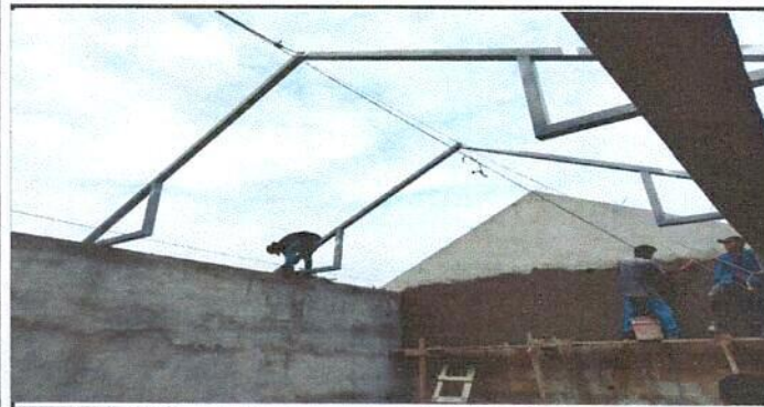
Foto 5: Sustitución de Estructura de madera por metal.
