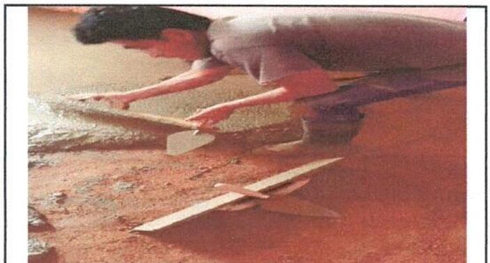
Foto 4: Reparación de piso.
