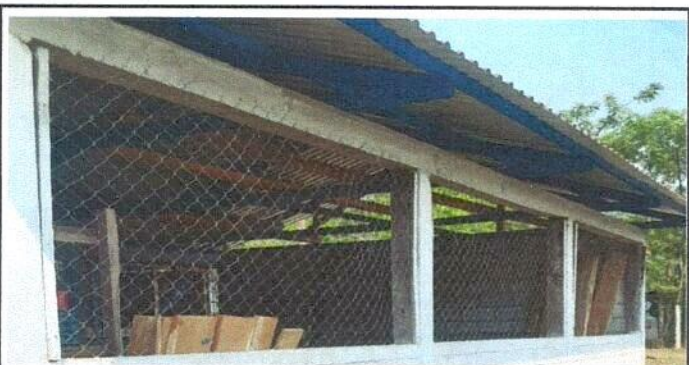
Foto 6: Sustitución de balcon.
