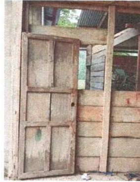
Foto 2: Sustitución de puertas.
