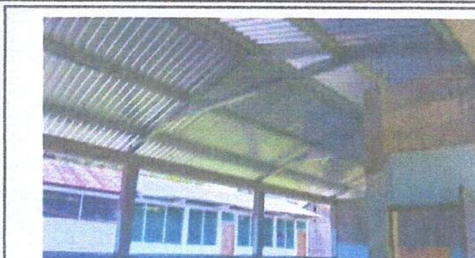
Foto 2: PARTE INTERNO DEL MODULO LAMINA INSTALADO
