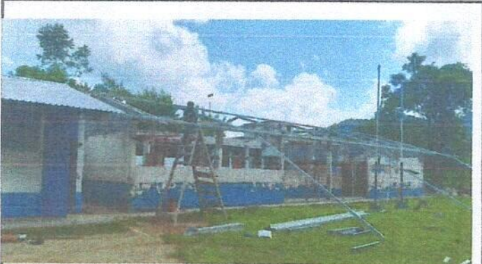
Foto 3: inicio de instalacion de estructuras metalicas.
