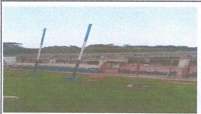
Foto 2: desmontaje de las laminas del modulo uno
