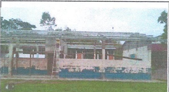
Foto 4: finalizacion de la colocacion de las estructuras de soporte de lamina.
