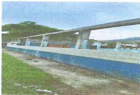
Foto 5: desmontaje de lamina
