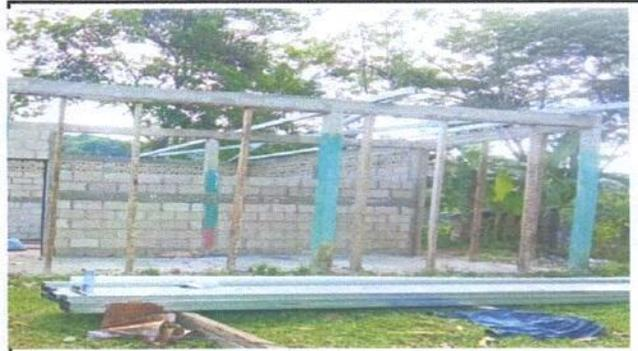
Foto 2: Proceso de sustitución de estructura de soporte de madera, por metal del centro educativo público.
