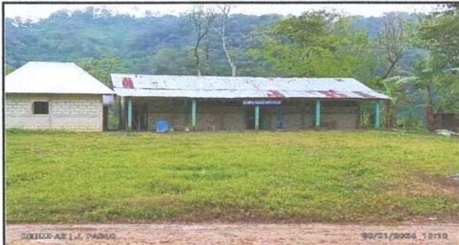
Foto 1: Sustitución de lámina por lámina troquelada del centro educativo público.
