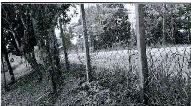
Foto 4: Reparación de muro perimetral de malla con tubo hg y malla galvanizada
