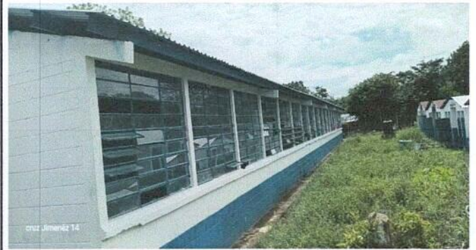
Foto 2: Vista lateral del centro educativo montada de lámina
