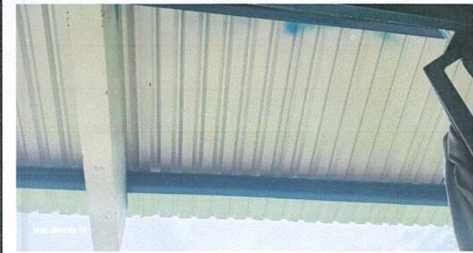
Foto1: Montada de láminas nueva.
