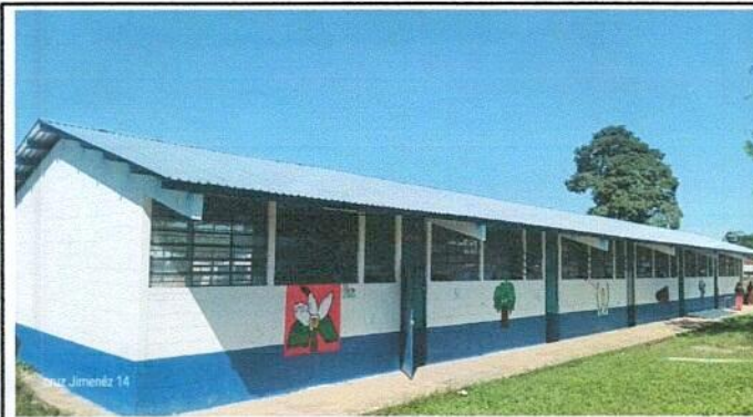
Foto 3: Vista de vigas con techado de lámina
