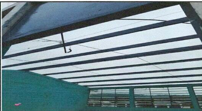
Foto 3: Vista de vigas pintadas
