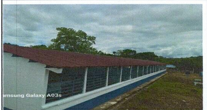
Foto 2: Vista lateral del centro educativo
