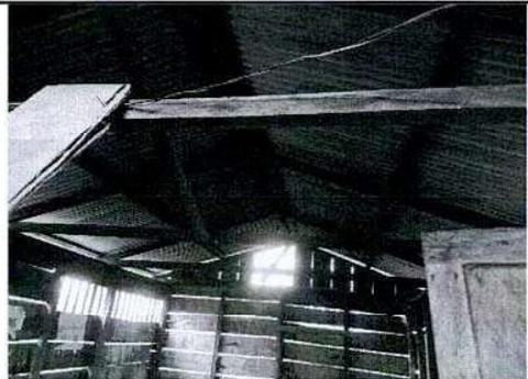
Foto 4: Estado del techo de galera, por lo que sustituiría por estructura de metal y lámina troquelada aluzinc.
