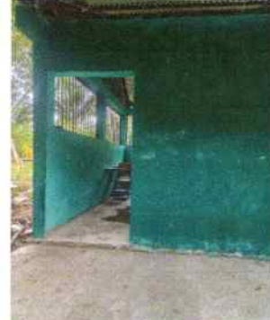
Aula de Módulo 2 con paredes pintadas
