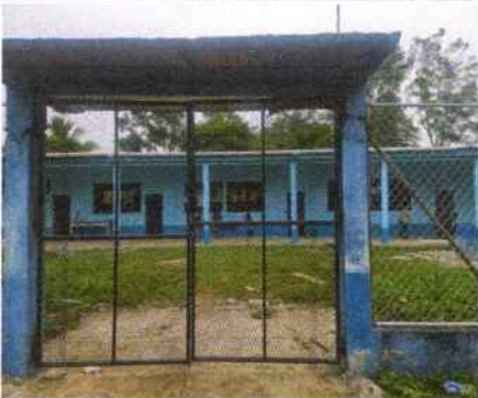
Portón reparado y pintado
