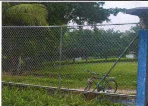
Muro perimetral con nuevos tubos HG
