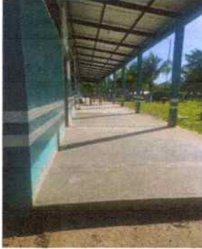
Corredor con nueva torta de piso liso
