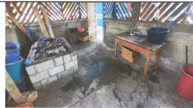
Foto 3: Cocina a intervenir estufa rural y piso de concreto.
