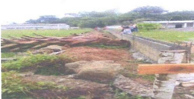
MURO PERIMETRAL PARTE DE ENFRENTE
