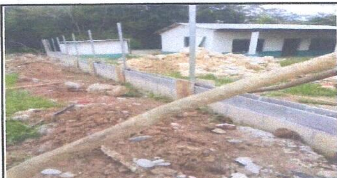
MURO PERIMETRAL PARTE DE ENFRENTE
