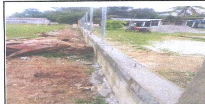
MURO PERIMETRAL PARTE FRENTE AL CAMPO
