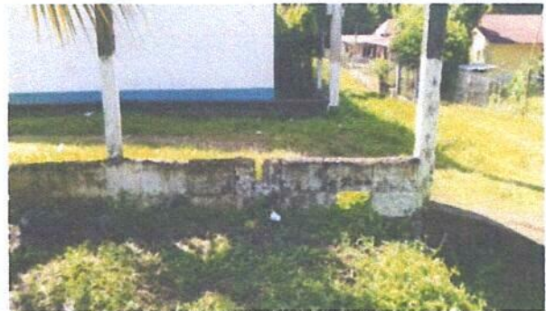
ESQUINA DEL MURO PERIMETRAL
