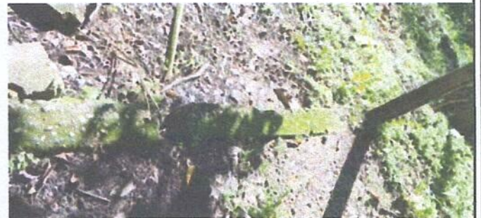
MURO PERIMETRAL LADO NOROESTE
