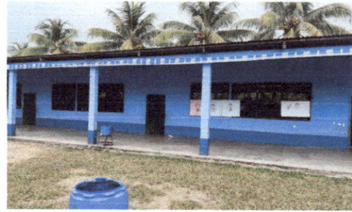
Foto 2: VISTA EXTERIOR DEL MODULO DE AULAS.
