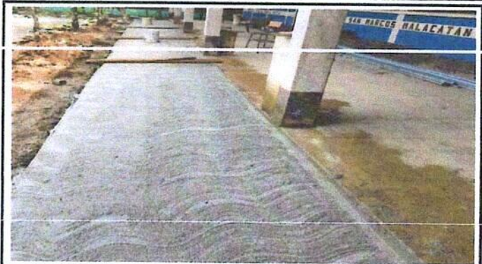
Foto 2: Reparacion de cuneta de concreto del centro educativo
