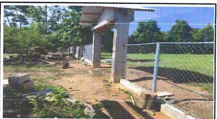
Foto 4: Reparacion de muros perimetrales del centro educativo
