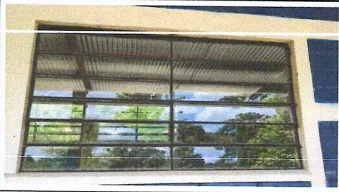
Foto 1: Sustitucion de vidrios del centro educativo
