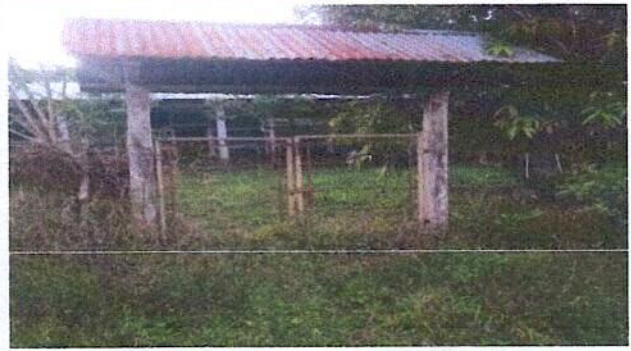
Foto 4: Reparacion de muros perimetrales del centro educativo
