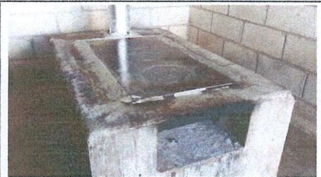
Foto 8: Sustitucion de plancha de metal de tres hornillas.
