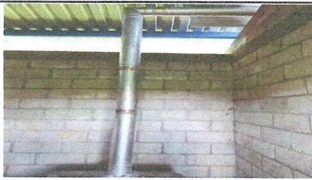
Foto 9: sustitucion de chimenea de concreto.
