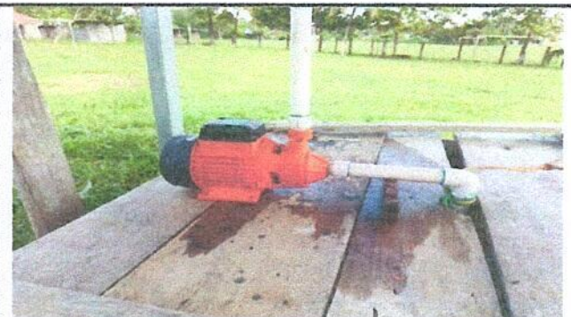
Foto 10: Sustitución de bomba de agua.
