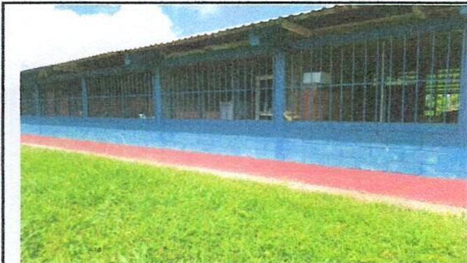
Foto 3: Mantenimiento a balcones de metal.
