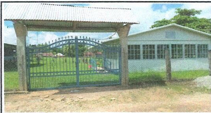
Foto 5: Mantenimiento a portones de metal.
