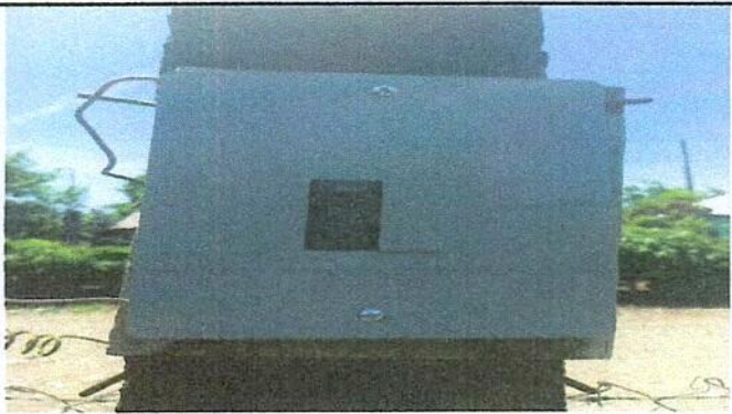
Foto 4: Instalación de tableros y flipones
