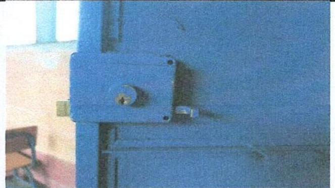
Foto 2: Sustitución de chapa de puerta
