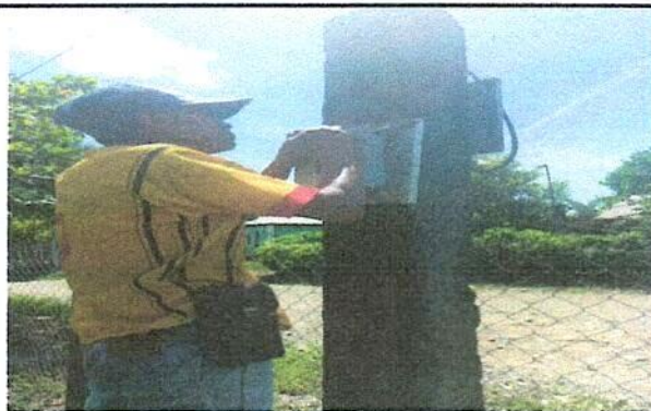
Foto 4: Instalación de tableros y filipones
