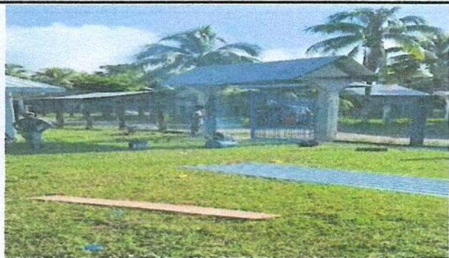
Foto 5: Mantenimiento a portones de metal.
