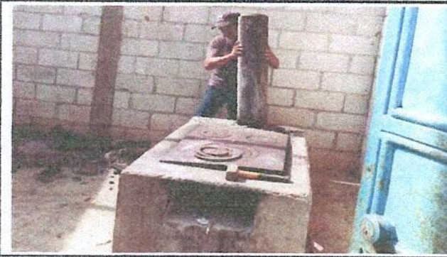
Foto 9: sustitución de chimenea de concreto.
