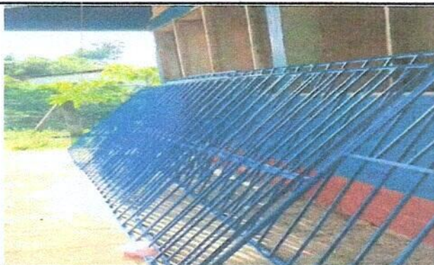
Foto 3: Mantenimiento a balcones de metal.
