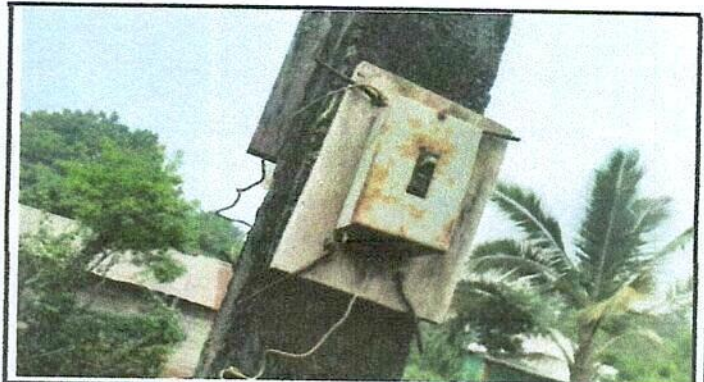
Foto 4: Instalación de tableros y flipones
