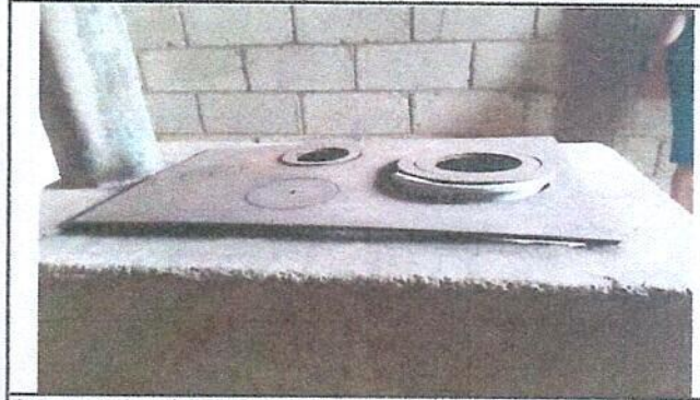
Foto 8: Sustitución de plancha de metal de tres hornillas.
