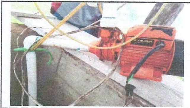
Foto 10: Sustitución de bomba de agua.
