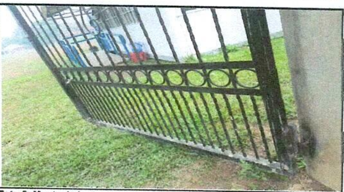
Foto 5: Mantenimiento a portones de metal.
