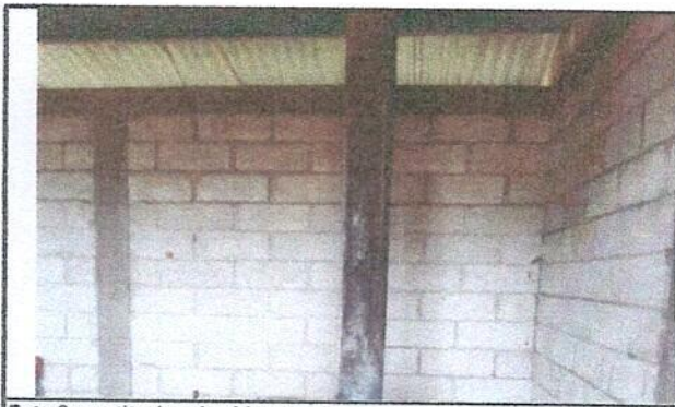
Foto 9: sustitución de chimenea de concreto.
