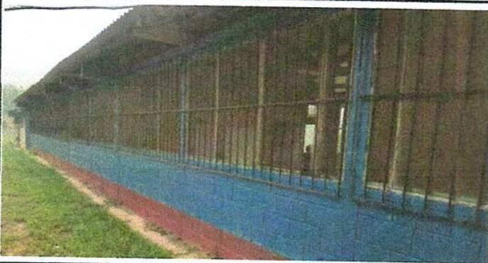
Foto 3: Mantenimiento a balcones de metal.
