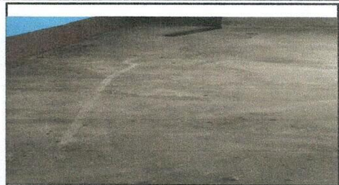
Foto 8: Reparación de torta de cemento
