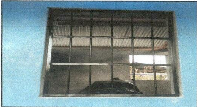
Foto 3: Pintura en muros exteriores e interiores
