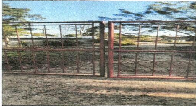
Foto 9: Reparación de portón de metal
