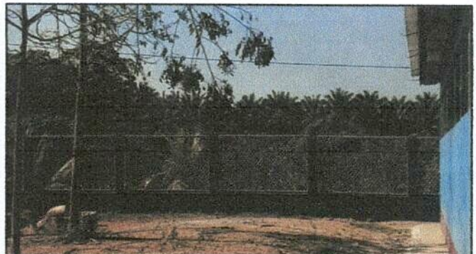
Foto 4: Reparación de malla por maya galvanizada
