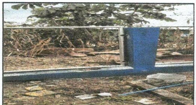
Foto 4: Reparación de malla por maya galvanizada
