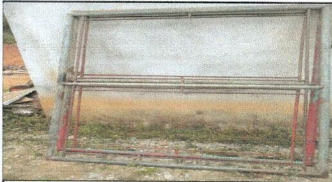
Foto 9: Reparación de portón de metal
