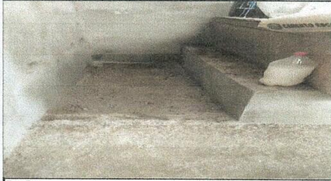
Foto7: Reparación de polletón de cocina
