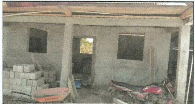
Foto 2: Sustitución de ventanas de madera por balcones de metal
