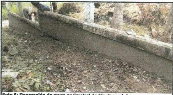
Foto 5: Reparación de muro perimetral de block con tubo
