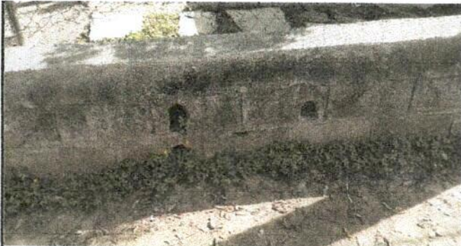
Foto 5: Reparación de muro perimetral de block con tubo
