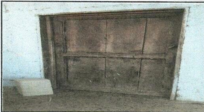
Foto1: Sustitución de puertas de madera por metal
