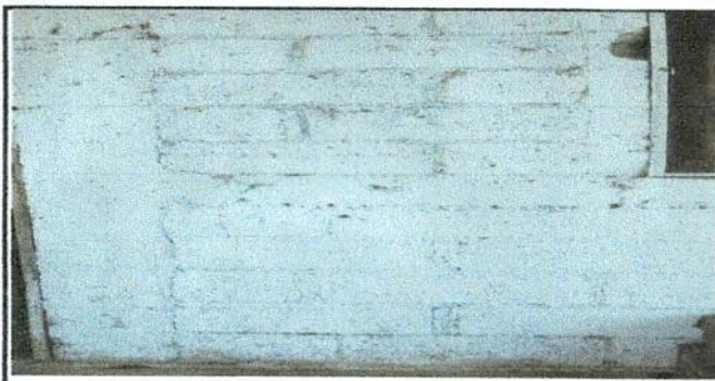
Foto 3: Pintura en muros exteriores e interiores
