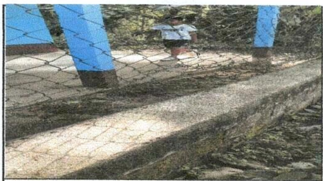
Foto 4: Reparación de malla por maya galvanizada
