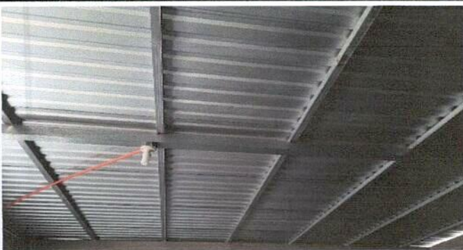
Foto 3: ESTRUCTURA DE TECHO
