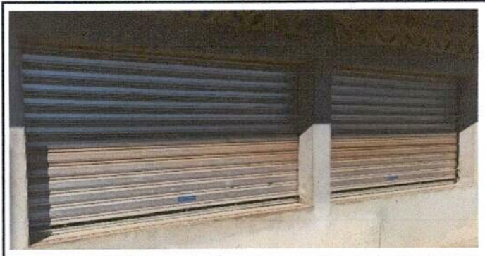
Foto 6: VENTANA DE METAL
