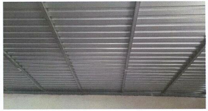
Foto 2: CUBIERTA DE LAMINA
