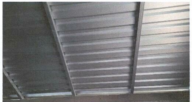
Foto 4: CUBIERTA DE LÁMINA
