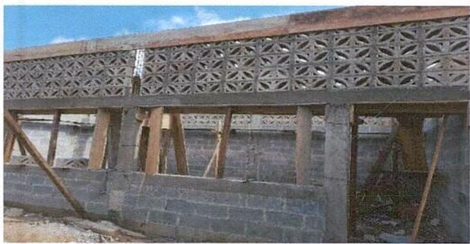
Foto 5: PUERTA Y VENTANAS
