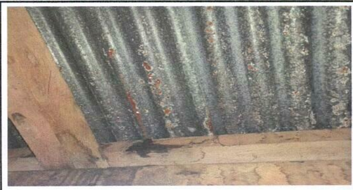
Foto 4: CUBIERTA DE LÁMINA
