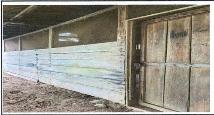
Foto 5: PUERTA Y VENTANAS
