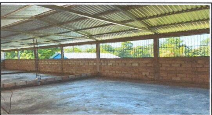
Foto 6: Piso de concreto instalado en la parte norte.
