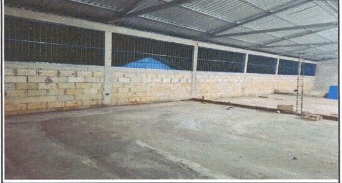
Foto 2: Finalización de instalación.
