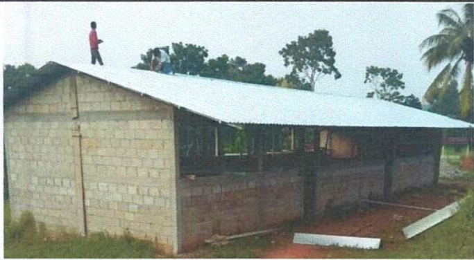
Foto1: Lámina troquelada aluzinc calibre 26 instalada
