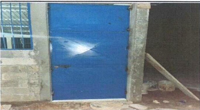
Foto 3: Puertas de metal instaladas.
