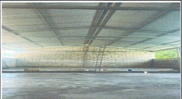
Foto 2: Estructura de de techo de metal metal instalada.
