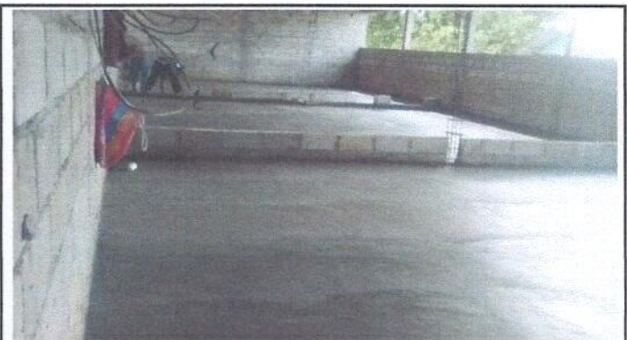
Foto 4: Piso de concreto instalado en la pared sur.
