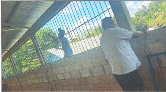
Foto 2: Instalación de balcones.
