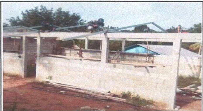
Foto 2: Instalacion de estructura de techo de metal.
