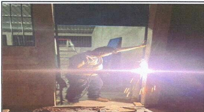
Foto 3: instalacion de puertas de metal.
