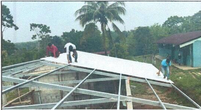
Foto1: Instalacion de lámina troquelada.
