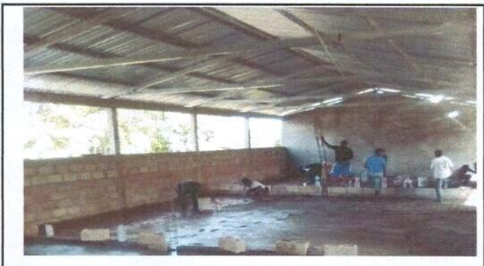
Foto 4: Sustitución de piso de torta a piso de concreto en la parte sur.
