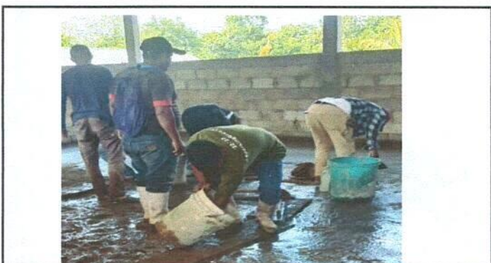
Foto 6: Sustitución de piso de torta a piso de concreto en la parte norte.
